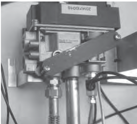
Abb. 3.1 Angeschlossener Gasregler
